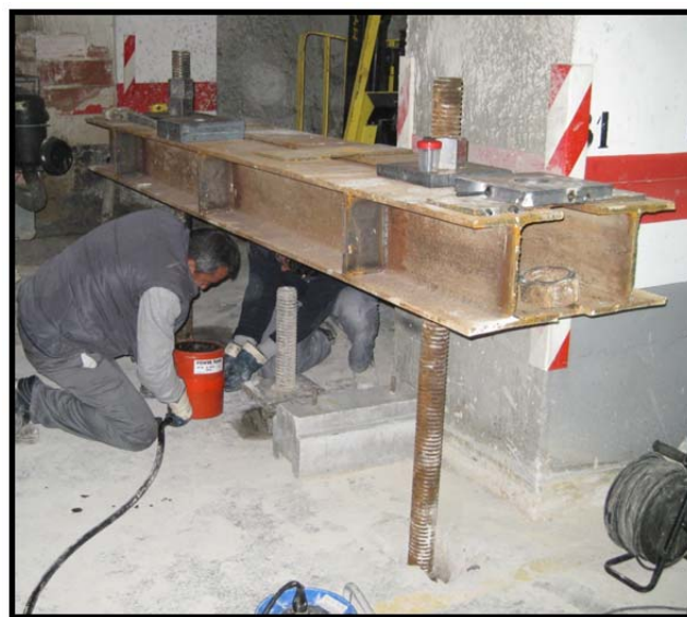
Fig 5. Vista de la colocación de la viga en los micropilotes.
