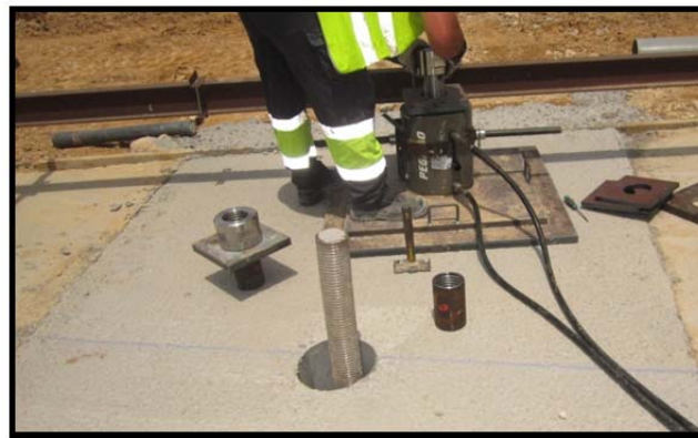
Fig 11. Fotografía mostrando la retirada del gato hidráulico Pegamo TMA 15015-P.
