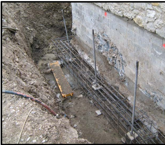
Imágenes de la construcción de la nueva viga en fase de colocación del armado.
