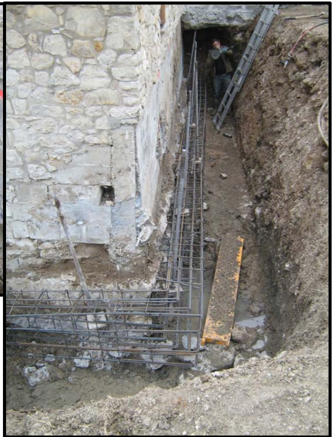
Imágenes de la construcción de la nueva viga en fase de colocación del armado.
