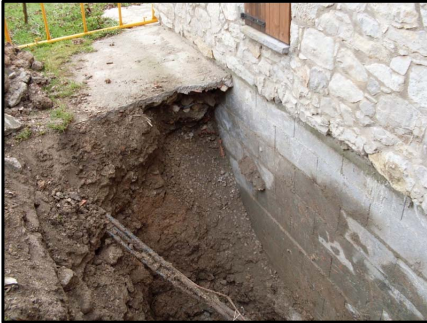
Imagen de la excavación de la zanja
