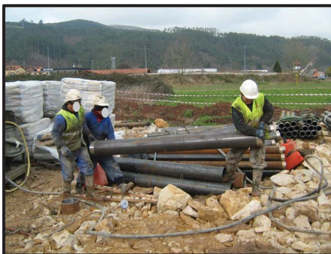
Fotografías de la colocación de la armadura del micropilote
